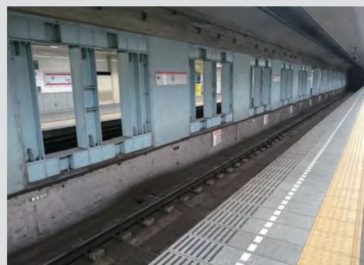
●地下鉄トンネル
